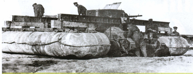
Танк БТ-5 с плавсредствами конструкции Кравцова, 1935 год.
